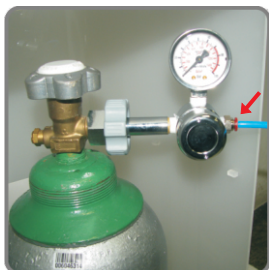
13-Acoplar a mangueira na válvula até travá-la, de maneira que ao tentar puxá-la para trás ela não se solte.
